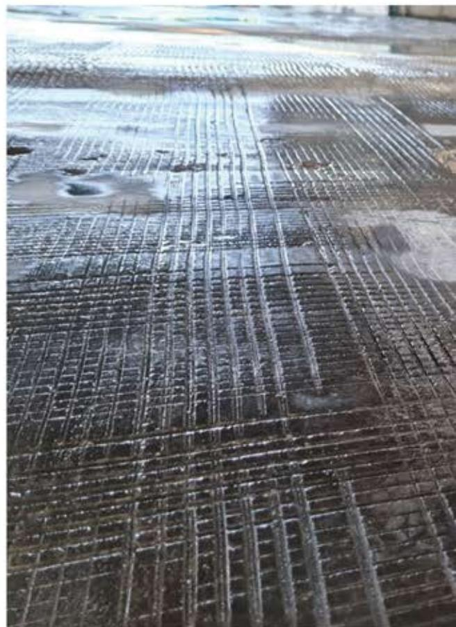
۳ در مرحله بعد پودر بتن پلیمری کم ضخامت با درصد مشخصی از آب (حدود ۱۰ درصد وزن پودر) با دستگاه همزن (میکسر) مخلوط می شود. ملات آماده شده را بر روی بستر ریخته و بعد از مدت زمان مشخص عملیات پرداخت با دستگاه ماله پروانه (ماله برقی) انجام می شود.
