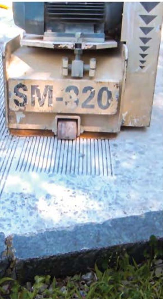
۱ ابتدا قسمت و نواحی سست بستر را از بین برده تا از یک سطح محکم و سخت اطمینان حاصل شود. سپس با دستگاه مخصوص شیار زن، سطح مورد نظر را شیار زده تا بستر مثل گل میخ عمل کرده و برای اجرای بتن پلیمری کم ضخامت آماده شود.
